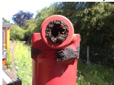
Pomp uit vloerverwarming.
